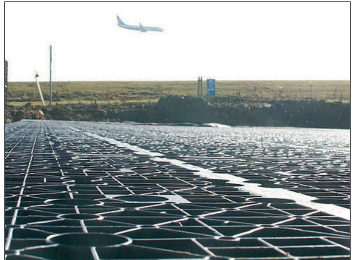
Onder een deel van de nieuwe parking op Brussels South Charleroi Airport werd een ondergronds infiltratiebekken geïnstalleerd
