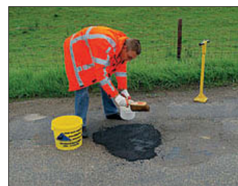
Na het aanbrengen het mengsel met water besproeien
