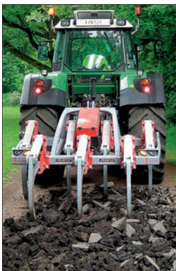
Met de 'ripper' wordt de slechte asfaltweg tot brokstukken herleid
