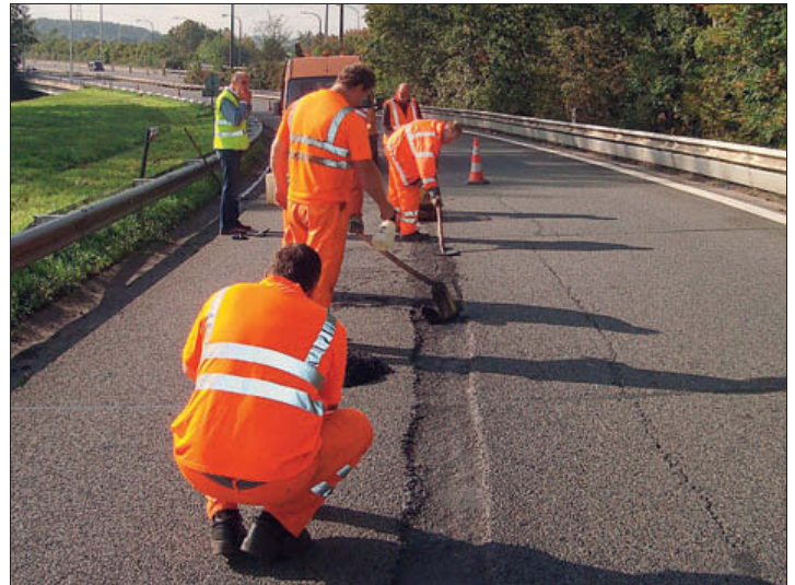
Het gebruik van gebruiksvriendelijk, duurzaam en snel uithardend waterreactief koudasfalt op snelwegen en drukke primaire wegen is voor de wegenarbeiders veiliger
