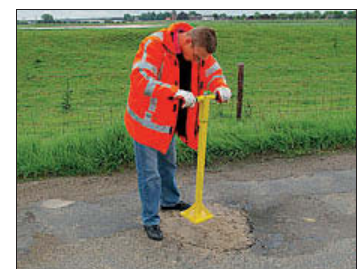
Meteen na het voorzien van water moet het mengsel verdicht worden
