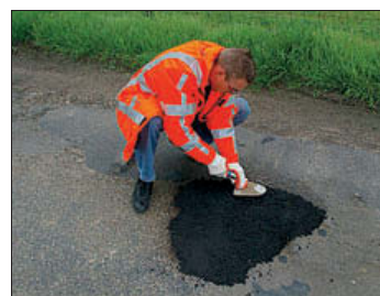
Waterreactief asfalt wordt aangebracht en verdeeld met een schop of troffel
