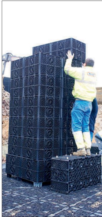
Via een eenvoudig kliksysteem kunnen de kratten snel gemonteerd worden
