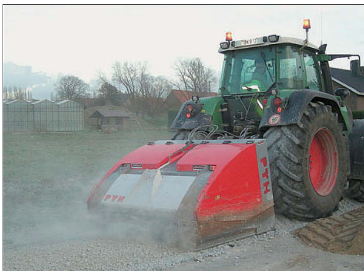
De 'crusher' pikt de brokstukken op en vermaalt ze tot kleinere steentjes. De gewenste grootte van stenen die de crusher verlaten, is instelbaar
