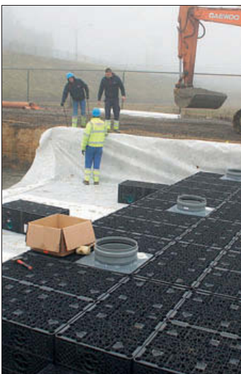
De hele infiltratieput werd ingepakt in geotextiel om zandindringing te voorkomen
