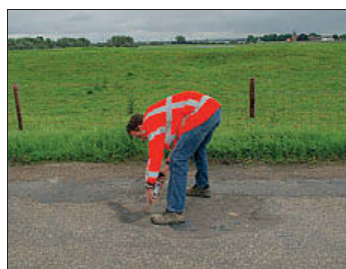
Soms wordt aangeraden om een speciale primer te gebruiken
