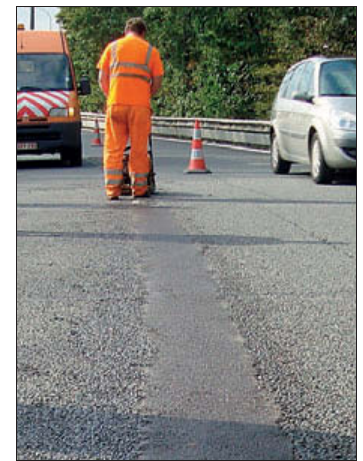
Een uitgehard waterreactief koudasfaltmengsel heeft een stabiliteit vergelijkbaar met die van warme asfaltmengsels
