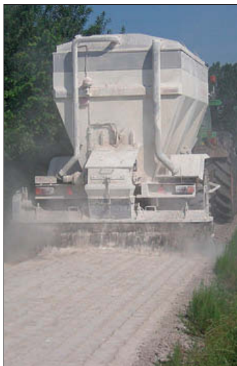
De kalkstrooier zorgt voor kalkcement, dat het uitgefreesde materiaal bindt
