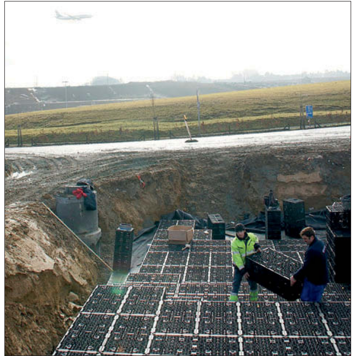
Elke krat, 120 cm lang, 60 cm breed en 42 cm hoog, bestaat voor 95% uit lucht, waardoor ze licht hanteerbaar zijn
